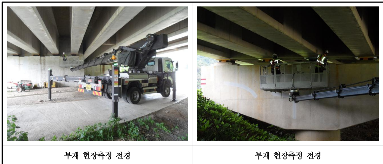
【사진 18.2.1】 부재 현장측정 전경
