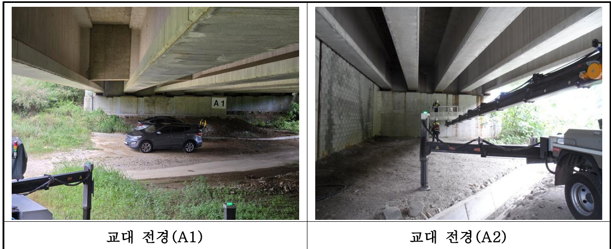
【사진 18.3.35】 교대 전경
