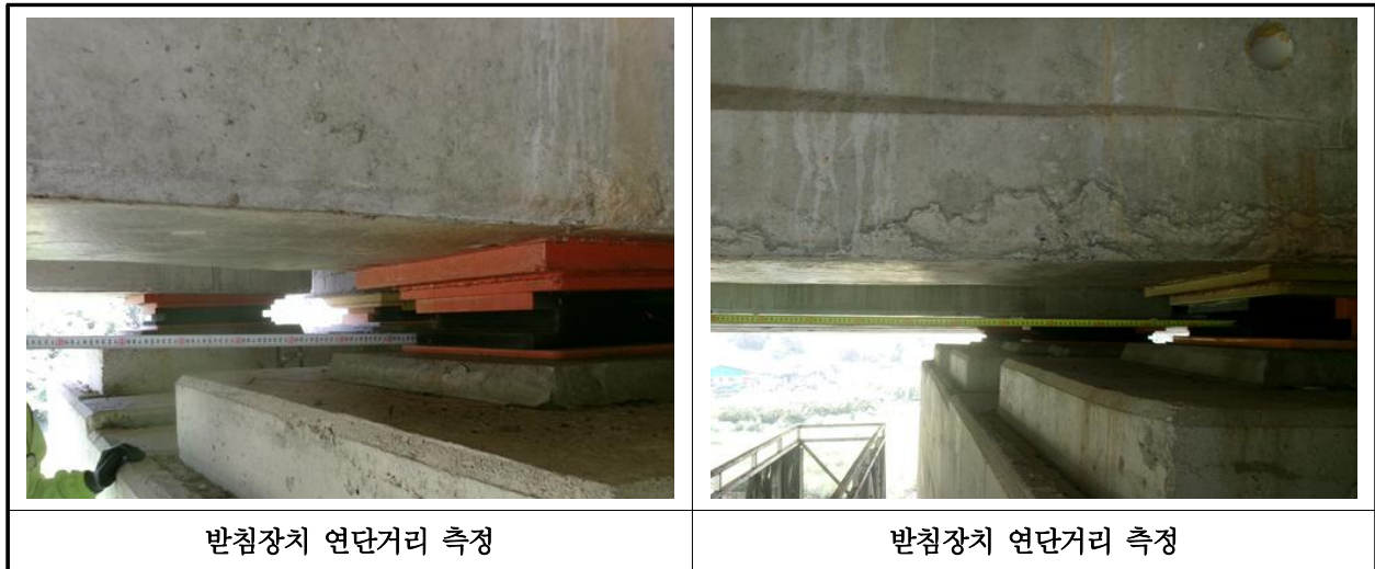
【사진 18.3.15】교량반침장치 연단거리측정
