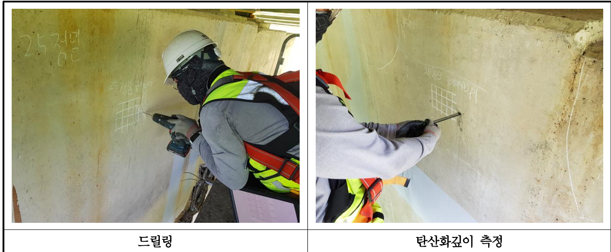
【사진 18.4.3】 탄산화 깊이 측정 현장사진
