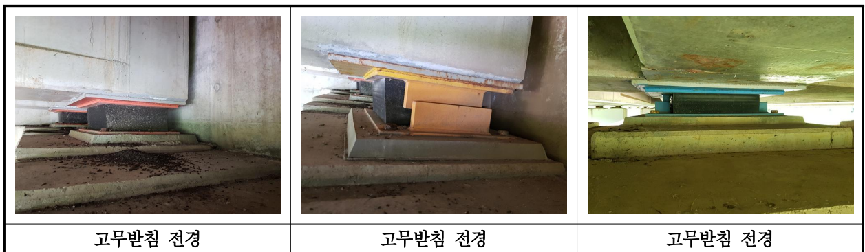
【사진 18.3.40】 교량받침 전경
