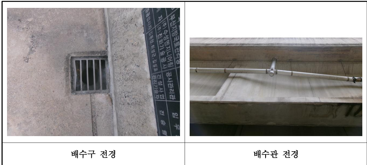
【사진 18.3.49】 배수시설 전경
