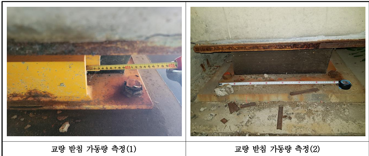
【사진 18.3.16】 교량받침 이동량 측정
