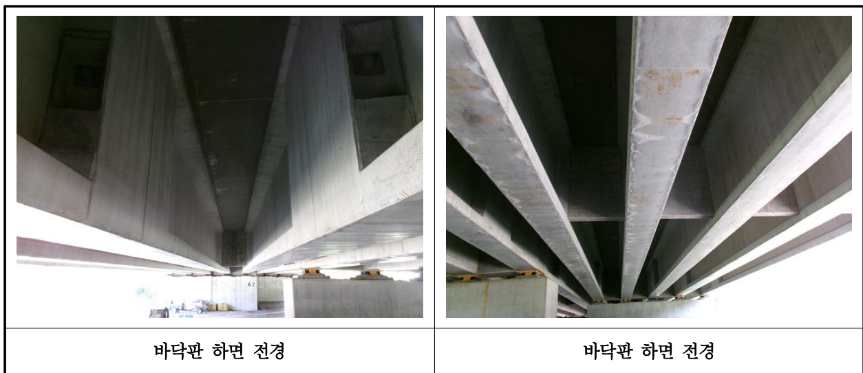
【사진 18.3.2】 바닥판하면 전경
