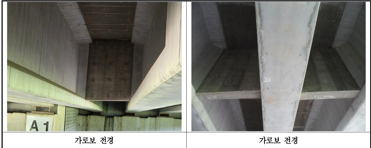
【사진 18.3.6】 가로보 전경
