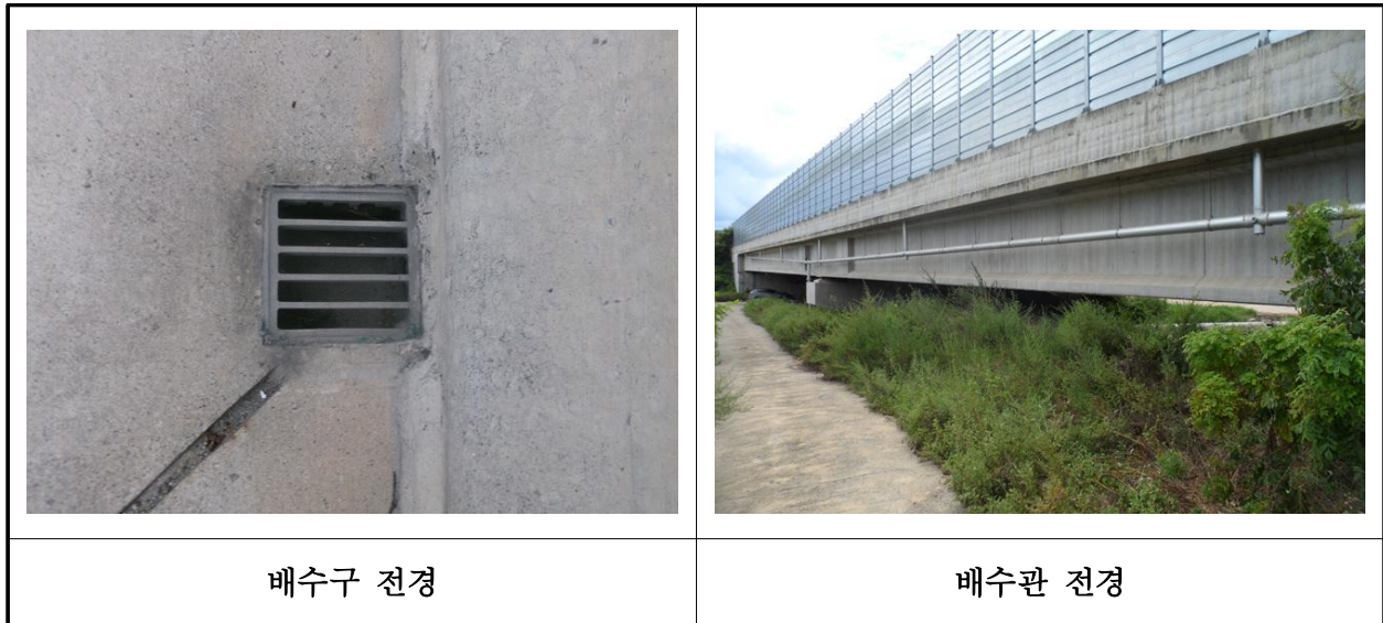
【사진 18.3.22】 배수시설 전경
