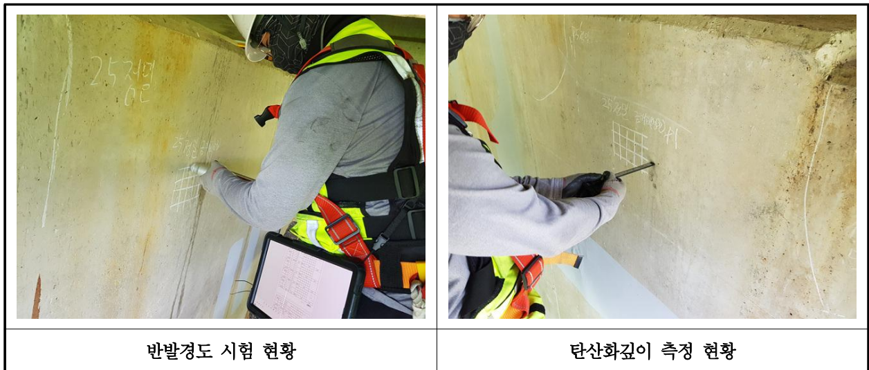
【사진 18.4.1】 콘크리트 내구성조사 현황
