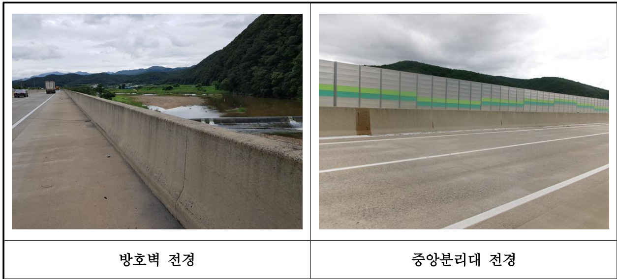
【사진 18.3.51】 방호벽 및 중양분리대 전경
