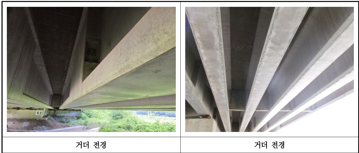
【사진 18.3.4】 거더 전경
