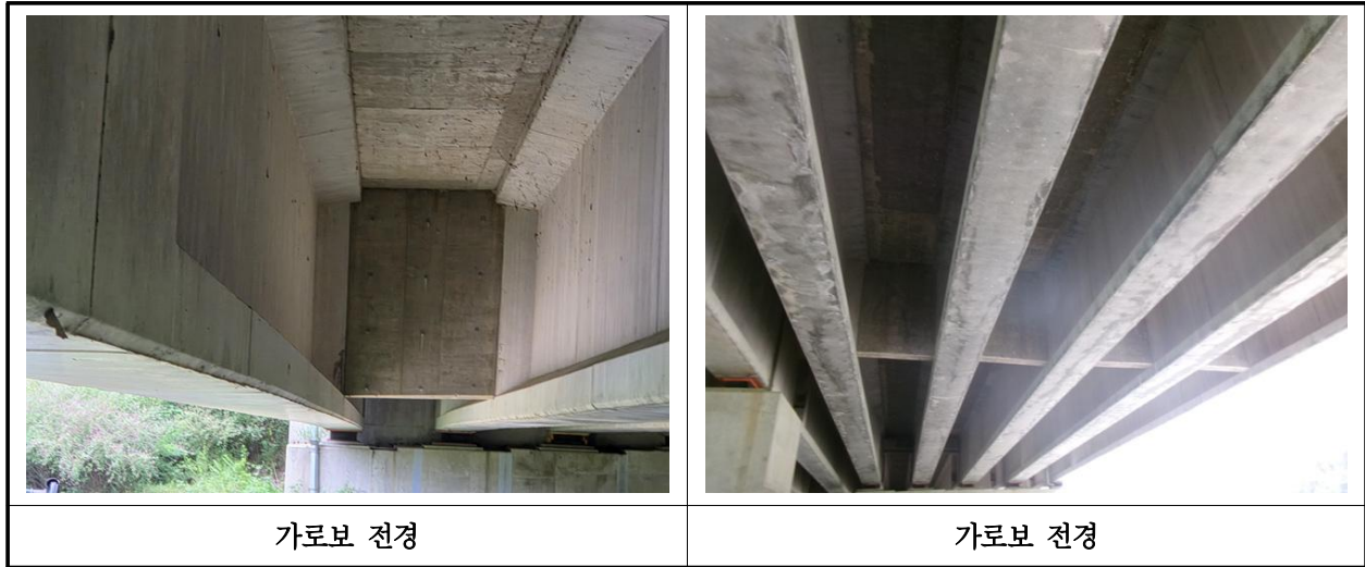
【사진 18.3.33】 가로보 전경
