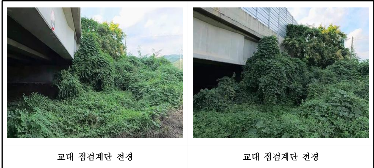
【사진 18.3.26】 교량 점검시설 전경
