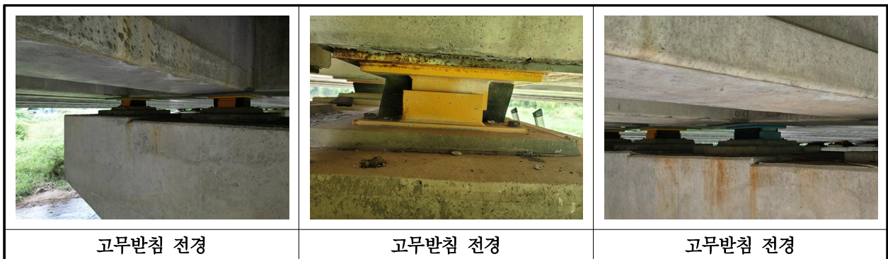
【사진 18.3.13】 교량받침 전경
