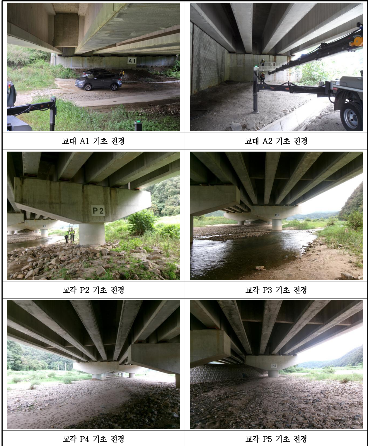
【사진 18.3.39】 기초 전경
