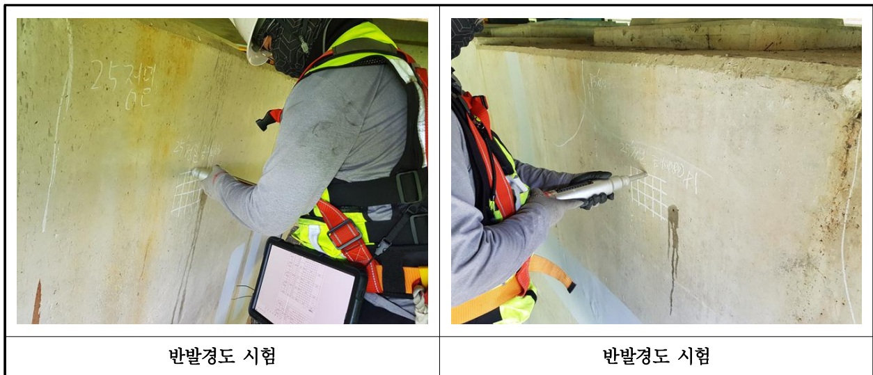
【사진 18.4.2】 반발경도시험 현장사진
