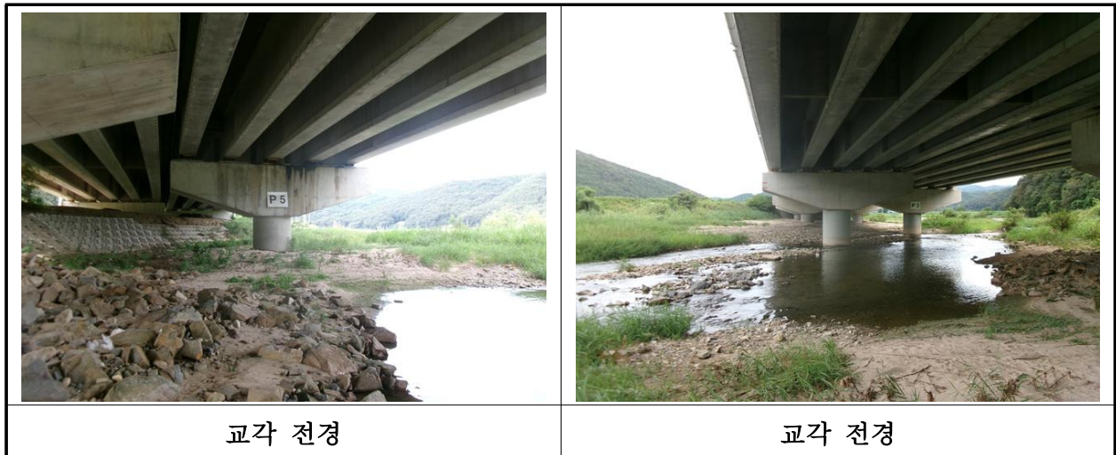
【사진 18.3.10】 교각 전경
