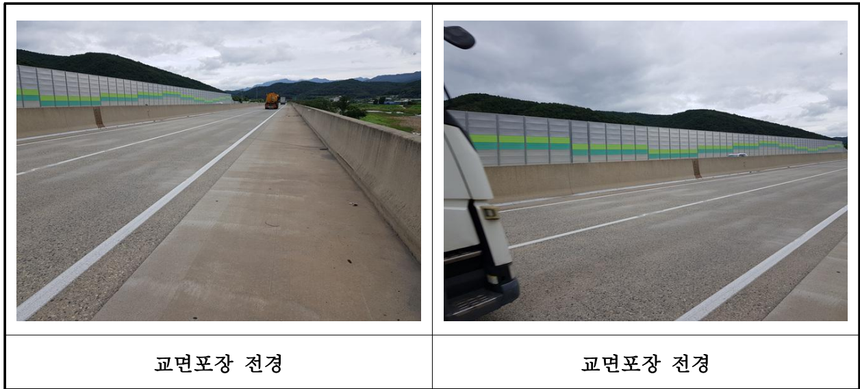
【사진 18.3.47】 교면포장 전경
