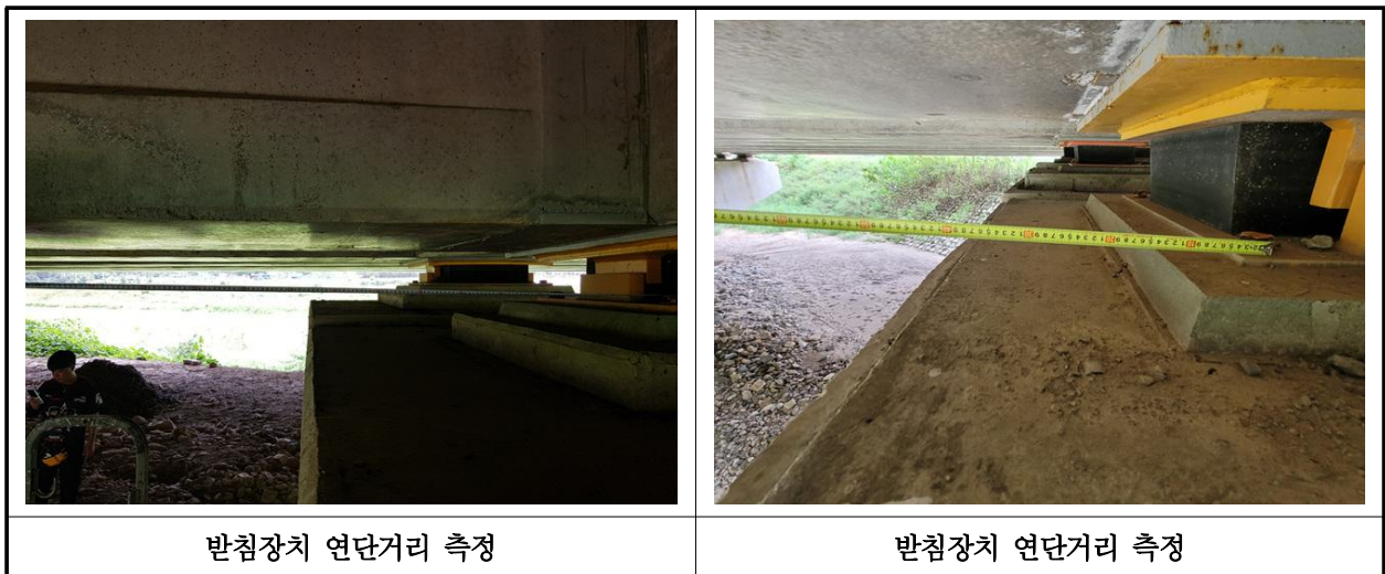
【사진 18.3.42】 교량받침장치 연단거리측정
