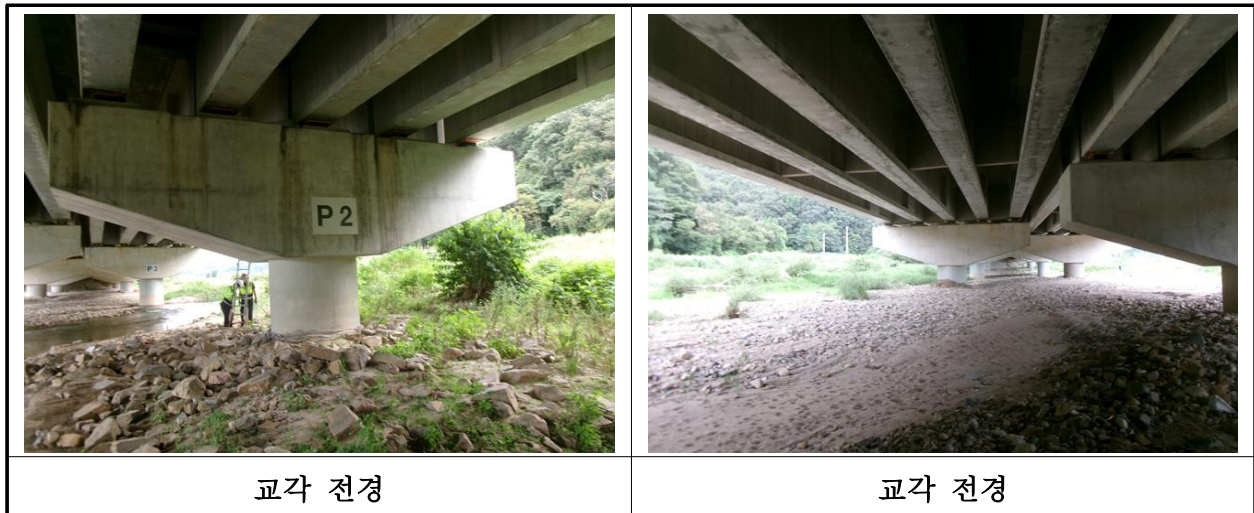
【사진 18.3.37】 교각 전경
