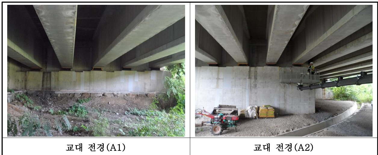
【사진 18.3.8】 교대 전경
